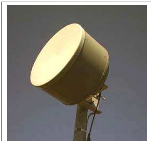
Antenne d'un Faisceau Hertzien
