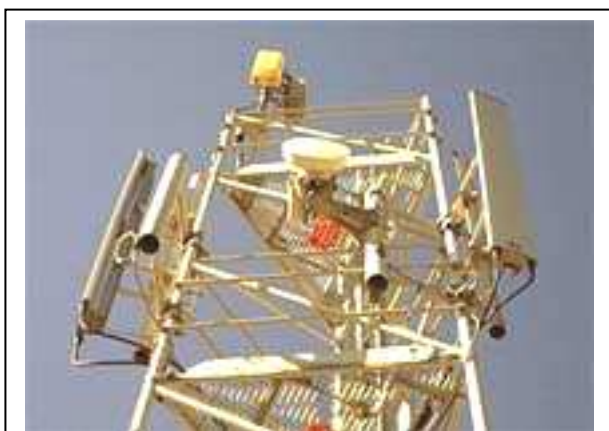
Site bisectorisé avec 2 antennes-panneaux directionnelles Bouygues Télécom – Firmi (12)
