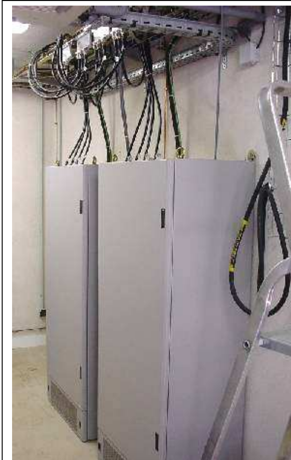
2 Baies Nortel Networks S8000 fermées vues de l'extérieur
