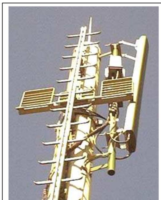
Antenne directionnelle avec tilt négatif SFR – Firmi (12)
