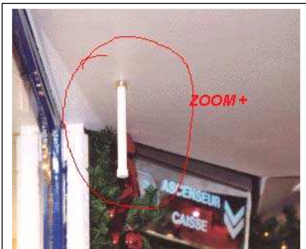
Antenne omnidirectionnelle pour micro cellule dans une galerie commerciale Orange France – St Germain en Laye (78)
