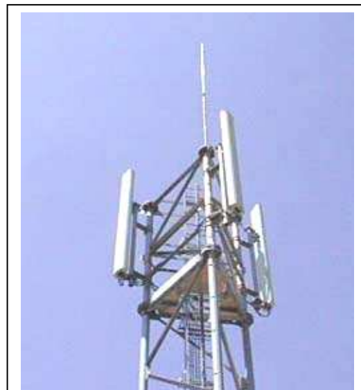
3 antennes directionnelles pour macro cellule Orange France – Porticcio (20)
