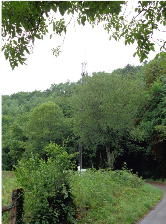
Figure 2 : Photo des antennes
