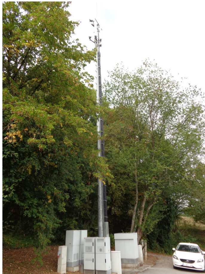
Figure 1 : Vue du site
