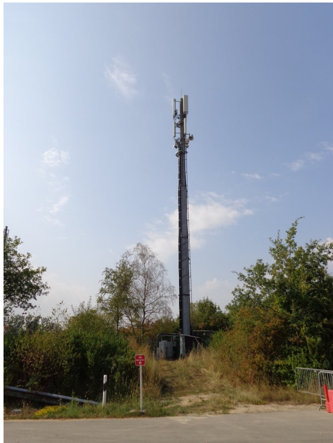
Figure 1 : Vue du site
