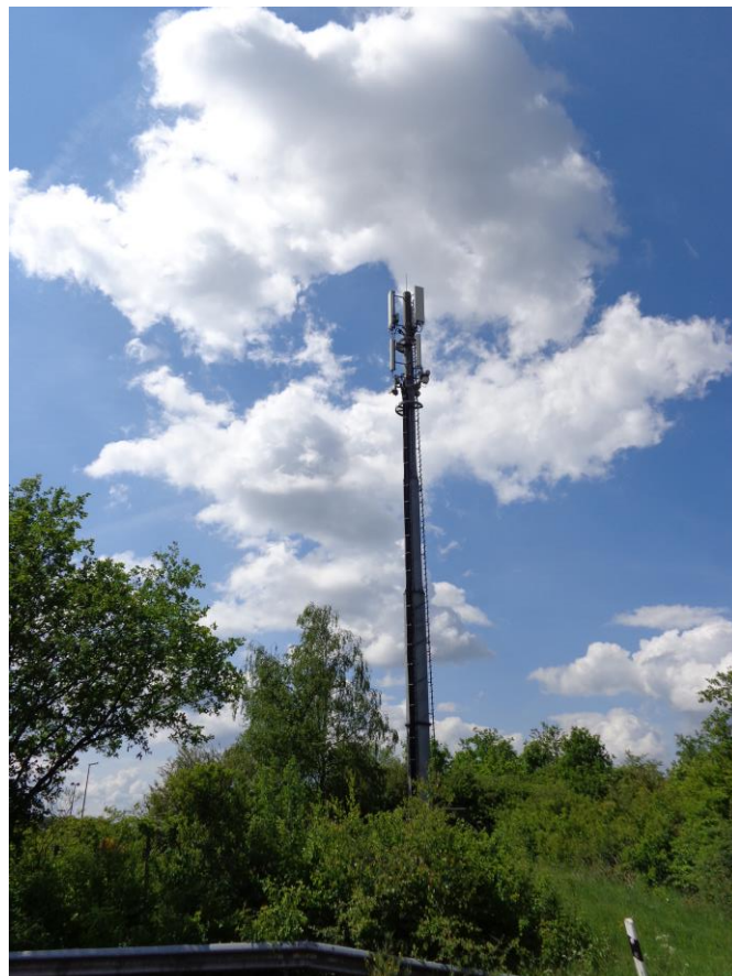
Figure 1 : Vue du site
