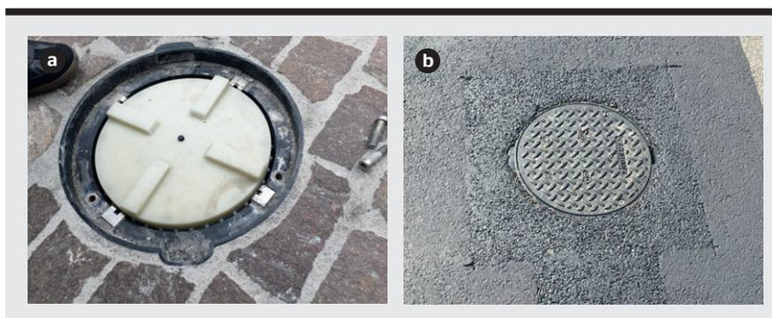
**Figure 3** Antenne installée dans le sol: dans son boîtier (a) et recouverte de son couvercle (b).
