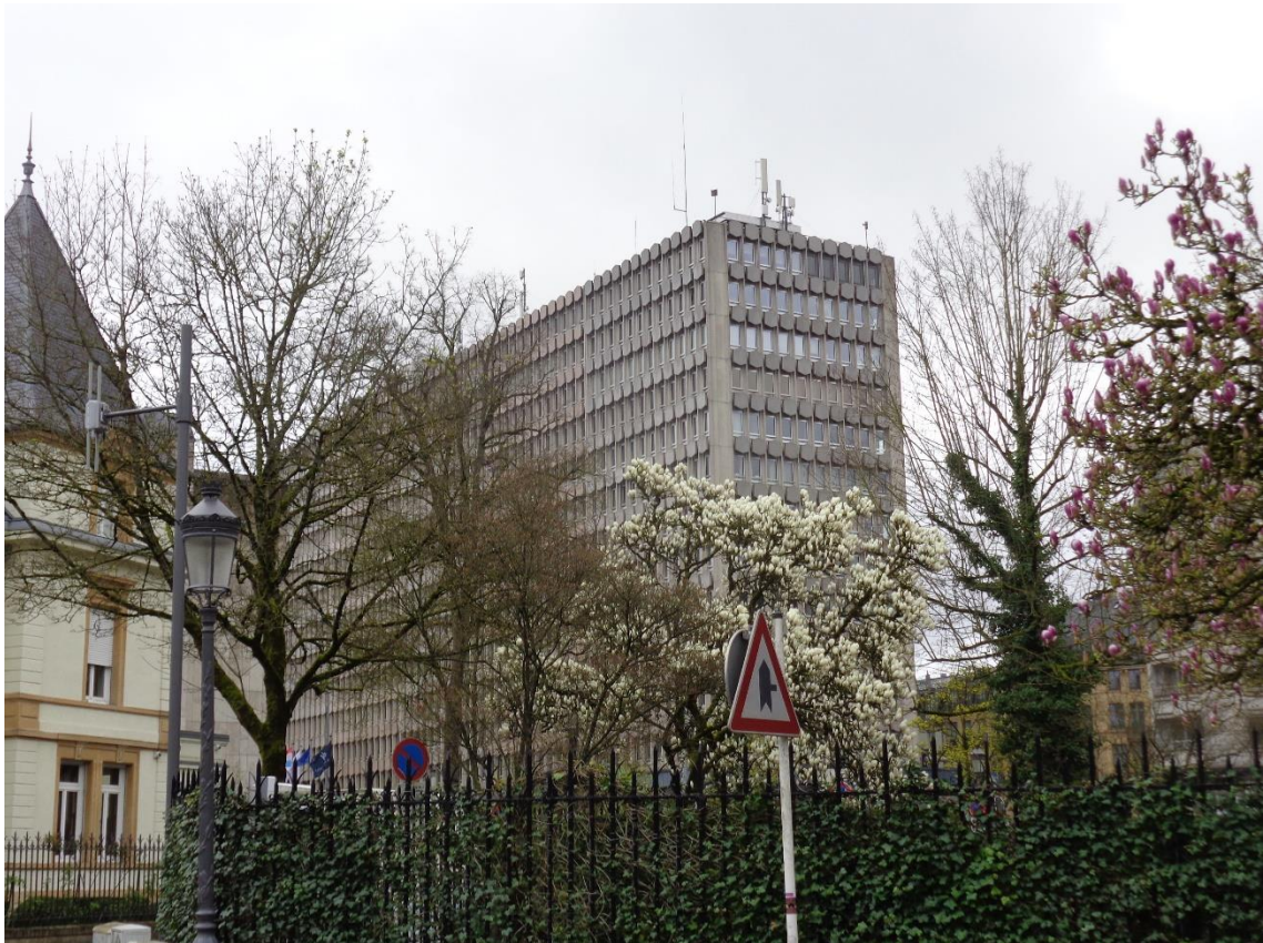
Figure 1 : Vue du site
