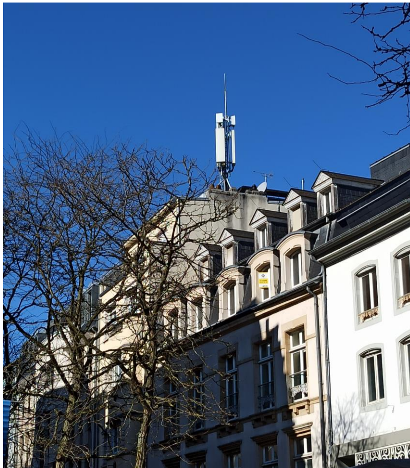
Figure 1 : Vue du site
