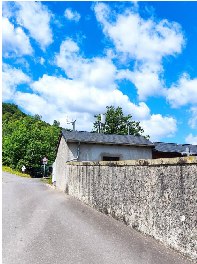
Figure 1 : Vue du site
