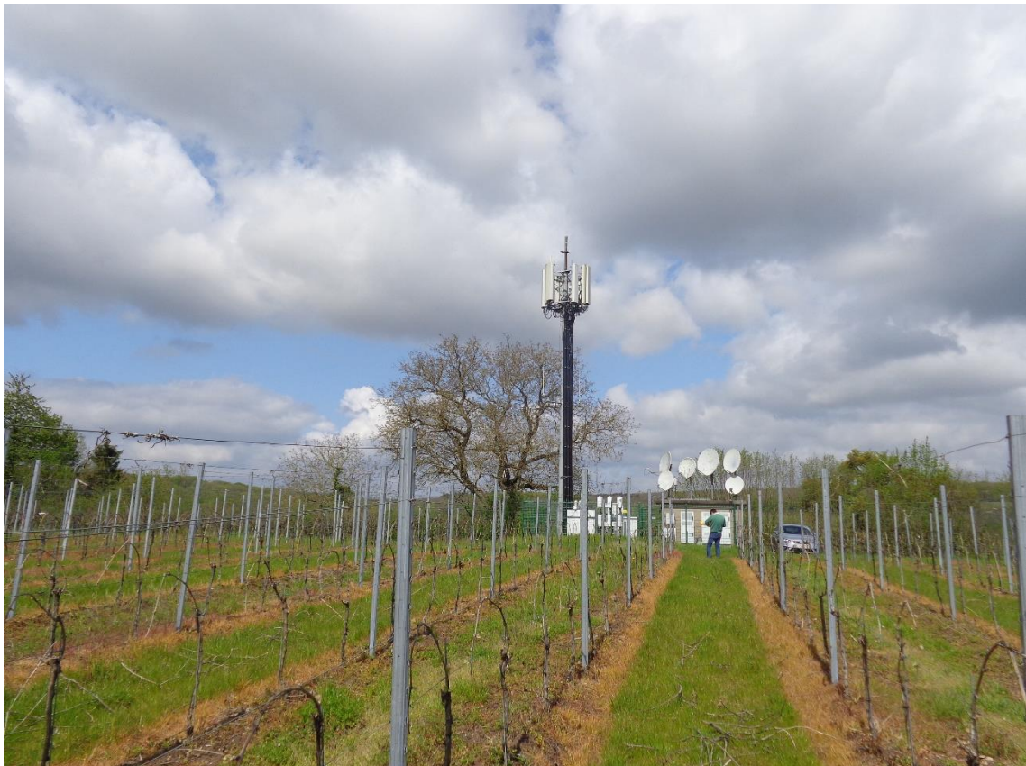
Figure 1 : Vue du site
