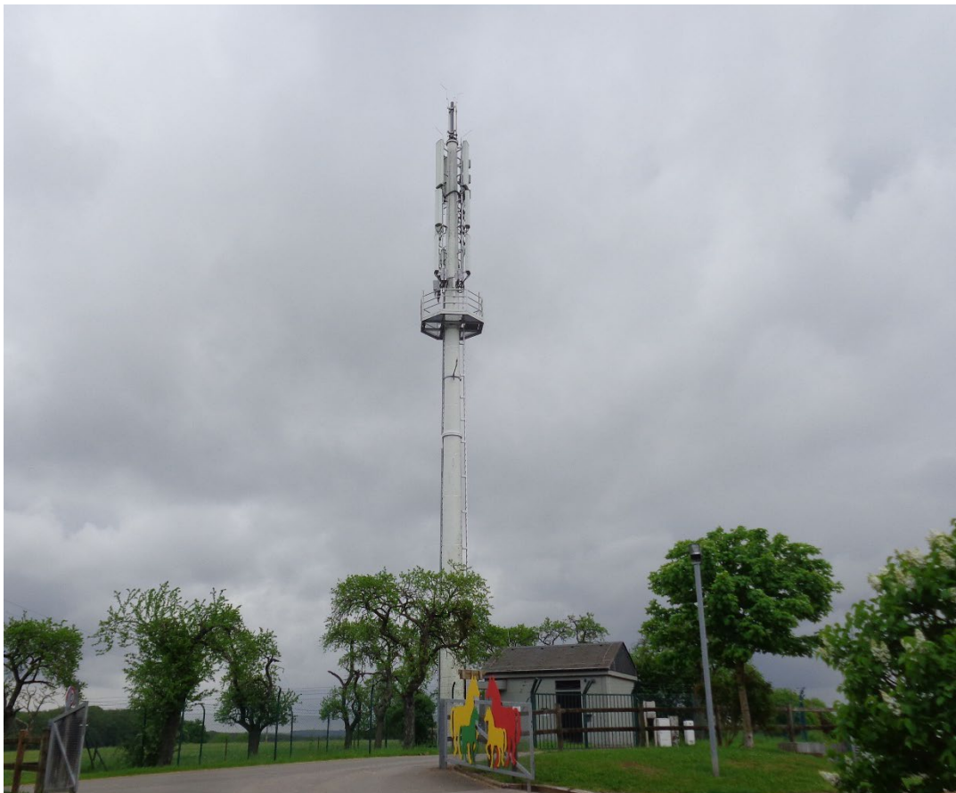
Figure 1 : Vue du site
