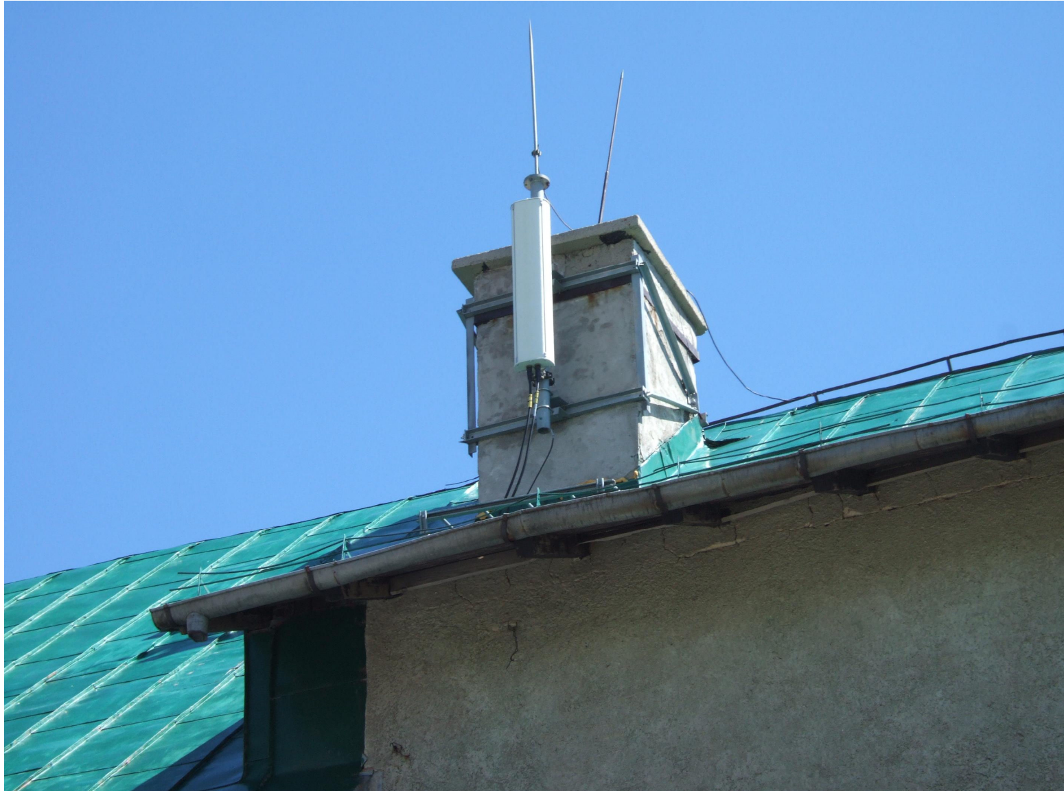
Al doilea sector Connex... ARFCN 21 - Bate în partea opusa fata de Cota 2000...
