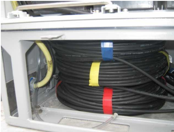
Excedente en base gabinete
