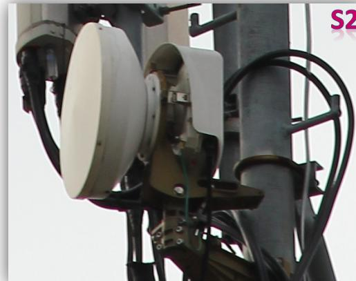
Interesant este faptul ca noua antena a fost montata pe acelasi suport, si mai precis defapt baietii nu au facut decât sa înlocuieasca ODU-ul – nu au atins deloc la reflectorul de 0.3m ! Asadar îți poti pune serioase întrebări asupra faptului daca acest LINK reprezinta ABIS-ul site-ului, sau este doar ceva de *backup* ?!
