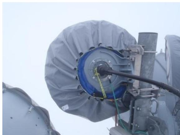
Figure 13 : Couverture chauffante installé sur site 38058 (Chamrousse)
