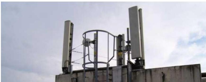
Figure 5 : Antennes radio sur terrasse
