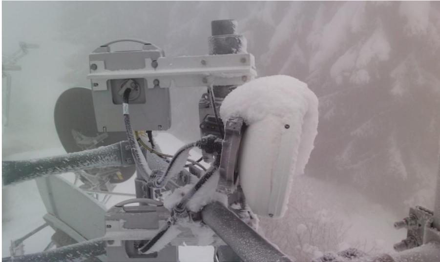
Figure 11 : Antenne FH couverte de neige
