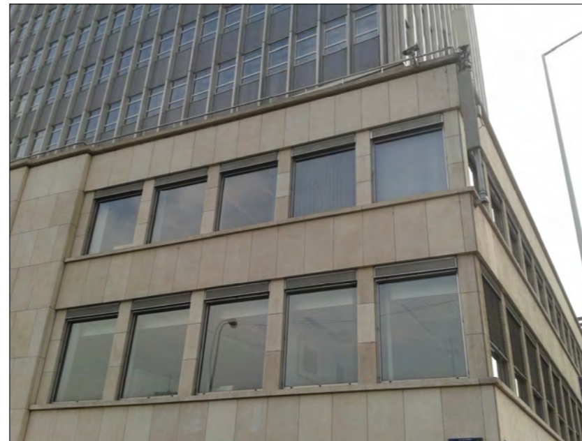
Vue facade secteur 1
