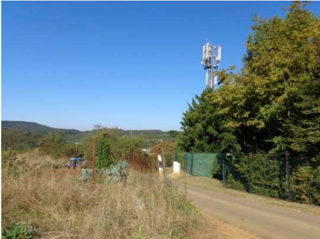
Figure 1 : Photo des antennes
