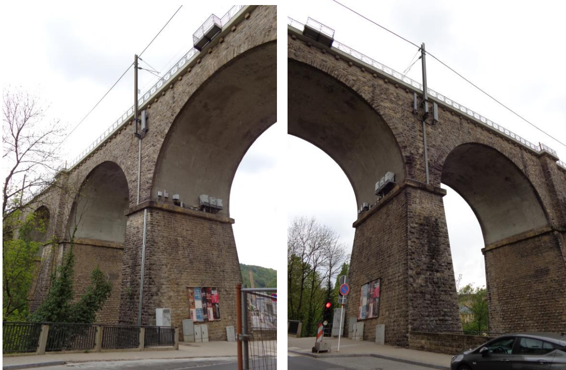
Figure 1 : Vues du site
