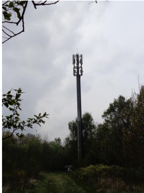
Figure 1 : Photo des antennes
