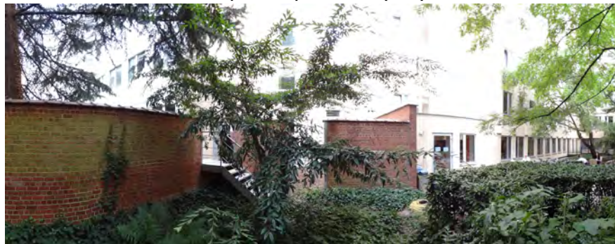
Vue facade des antennes
