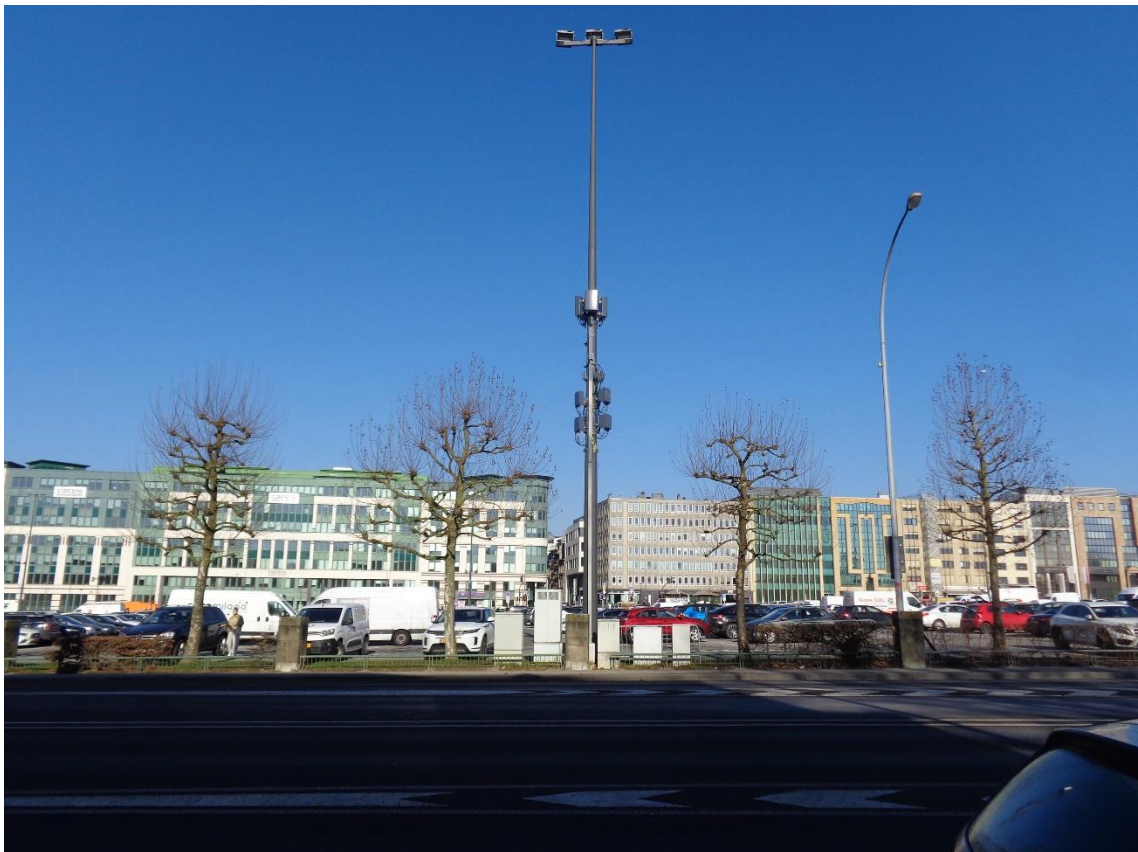
Figure 1 : Vue du site
